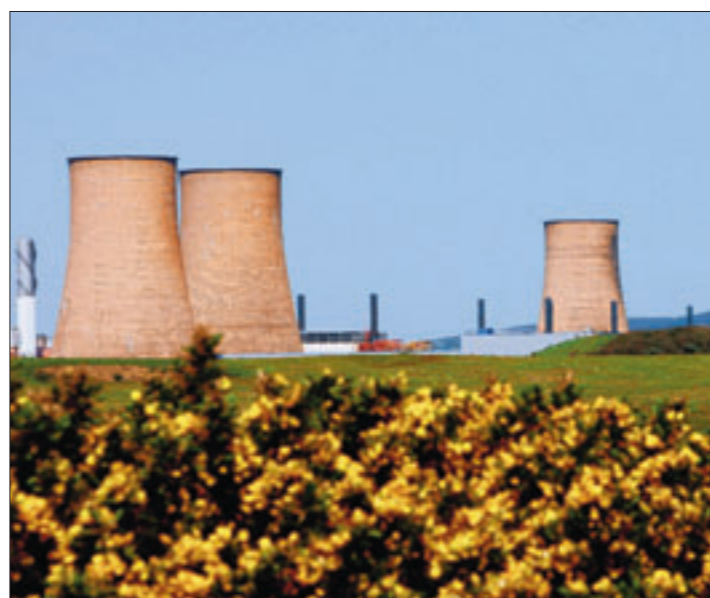
A cause du nucléaire, le Suédois Vattenfall aurait été contraint par son gouvernement à renoncer à son projet de rachat de British Energy.
